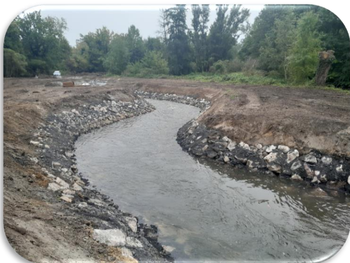
Bras de contournement mis en eau
