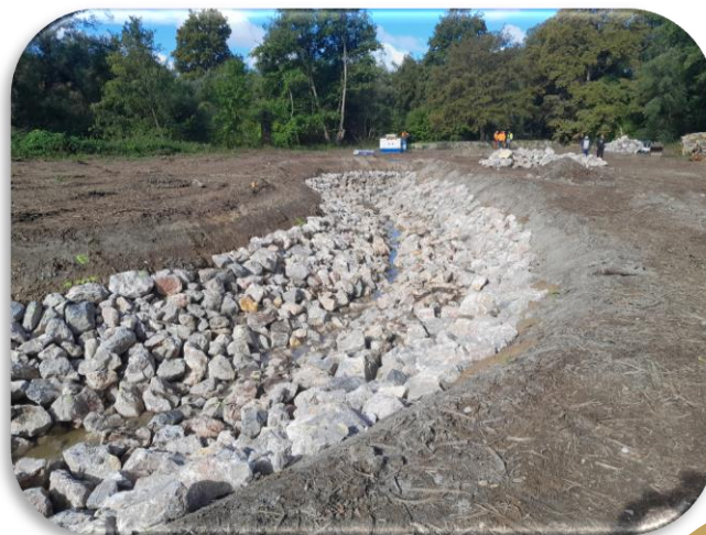
Bras de contournement en cours de création
