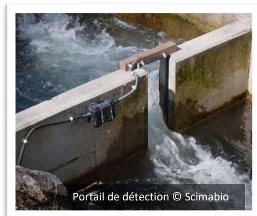
Pour détecter les poissons marqués, **4 « portiques » seront placés stratégiquement dans la rivière et le marais, et un détecteur mobile sera également utilisé** de façon à connaître de façon fine la position des poissons. Ce dernier sera porté à pied ou en canoë selon les milieux.
