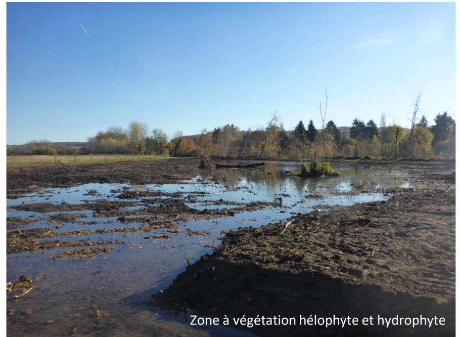
Bras mort à l'issu des travaux
