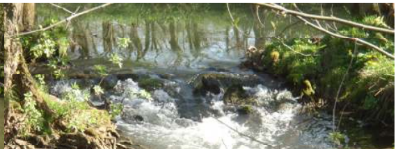
Ouvrage N°4 du moulin de Connigis (ROE 20048)
