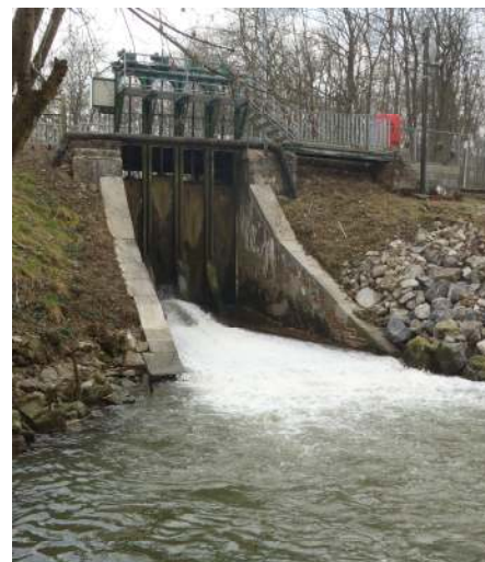
Vue aval de l'ouvrage de vidange du réservoir de Boué
