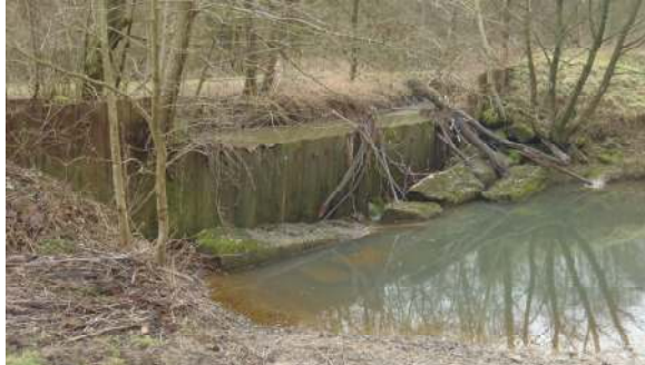
Vue aval du déversoir en palplanches
