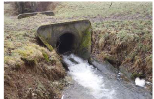
Vue aval d'un busage en amont de Buironfosse
