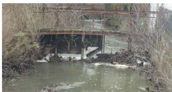
Vue amont des vannes à Martigny
