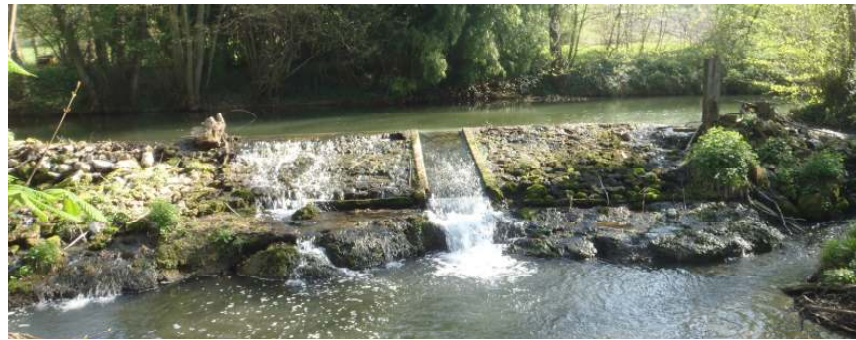
Ouvrage N°2 du moulin de Connigis (ROE 33470)
