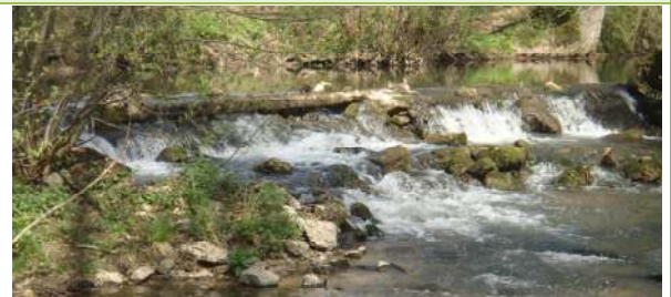
Ouvrage de Baulne-en-Brie (ROE 29431)
