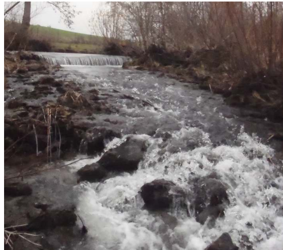
Partie N°3 de l'ouvrage constituée d'un petit seuil ainsi que d'une rampe empierrée
