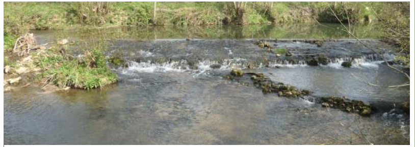
Seuil de l'ancien moulin de Monthurel
