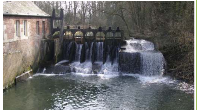
Vue aval du moulin d'Agnicourt-et-Séchelles Tavaux (Crédits photo : GRIVEAUX A-F)
