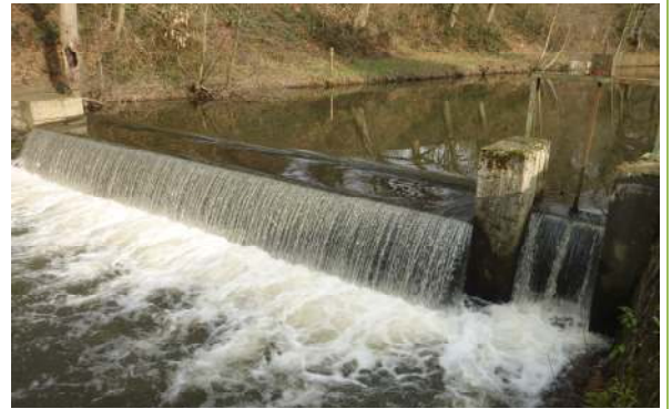
Vue aval du barrage de la piscine
