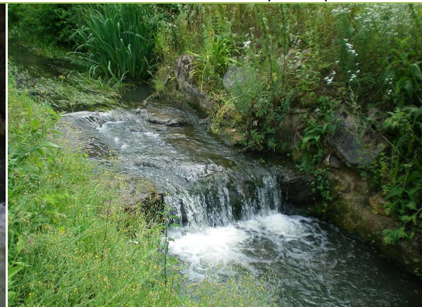
Un des deux seuils successifs (identiques) en aval du double seuil
