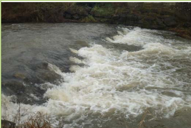
Vue du radier résiduel de l'ancien moulin de La Hérie
