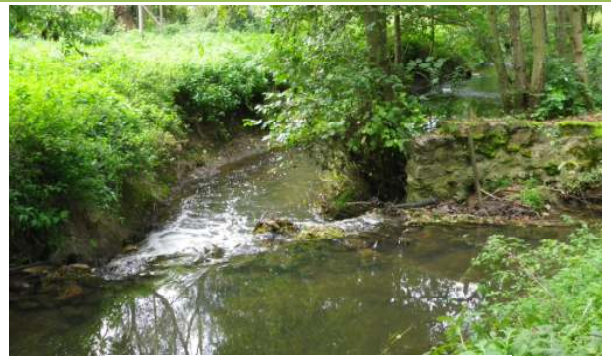
Seuil résiduel du moulin de Givray
