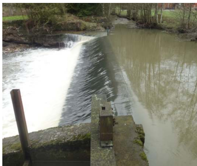
Vue aval du déversoir de Martigny
