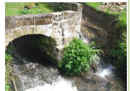
Vue aval de l'ouvrage
