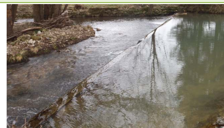
Ouvrage d'alimentation de l'ancien moulin de Chézy-sur-Marne
