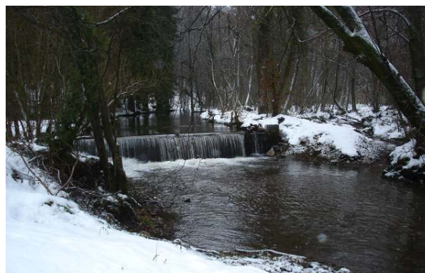
Vue aval du seuil en aval de Macquenoise (ROE3471) (Crédits photo : LOGEZ C.)
