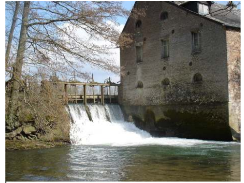
Vue aval du moulin d'Eparcy
