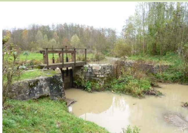
Vue du déversoir au niveau du bras de décharge
