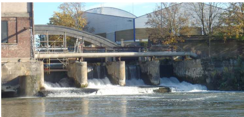
Vue aval du barrage Arkéma
