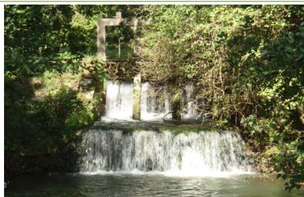
Vue aval du déversoir du moulin de Gercy amont
