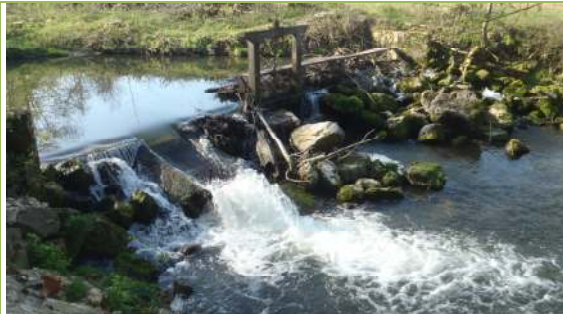
Ouvrage N°2 (ROE 31234)
