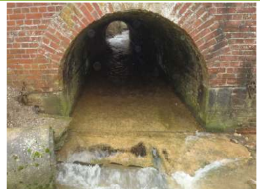
Vue aval du radier de pont à Buironfosse
