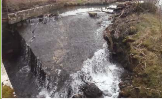
Partie N°1 de l'ouvrage constitué d'une rampe bétonnée
