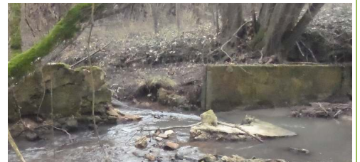
Vestige de prise d'eau
