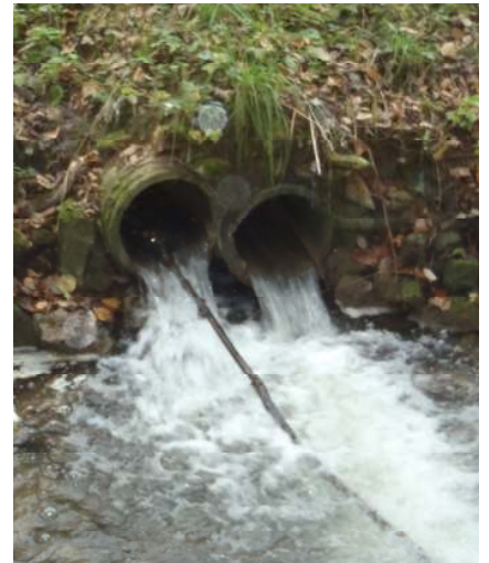
Vue aval de l'ouvrage « N°4 »
