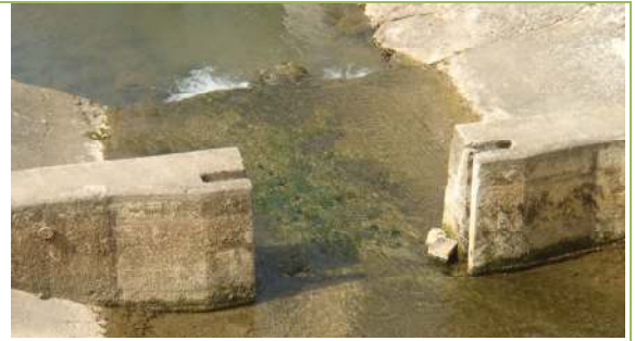
Seuil de la réserve d'eau en cas d'incendie
