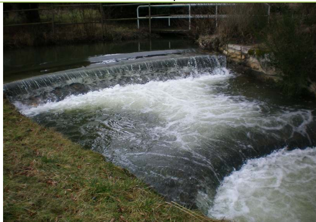
Double seuil du Moulinet pour alimenter le bras de l'ancien moulin
