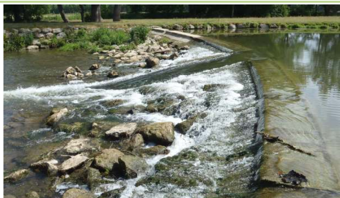
Vue de profil du déversoir en amont de Guise
