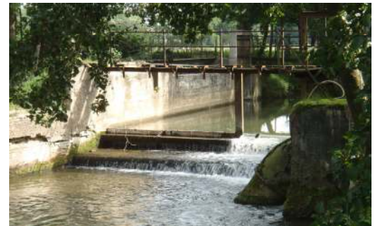
Vue aval du moulin de Prisces
