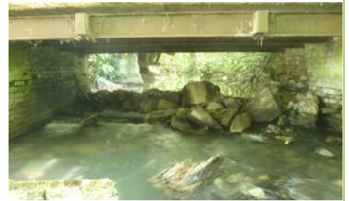
Vue aval de l'ouvrage N°2 du Péron
