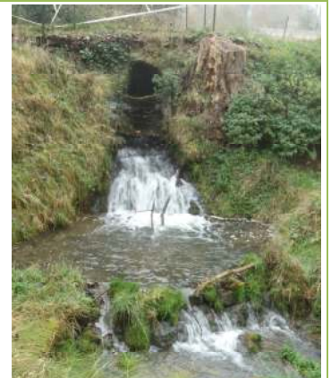
Vue aval des 2 ouvrages « N°1 »
