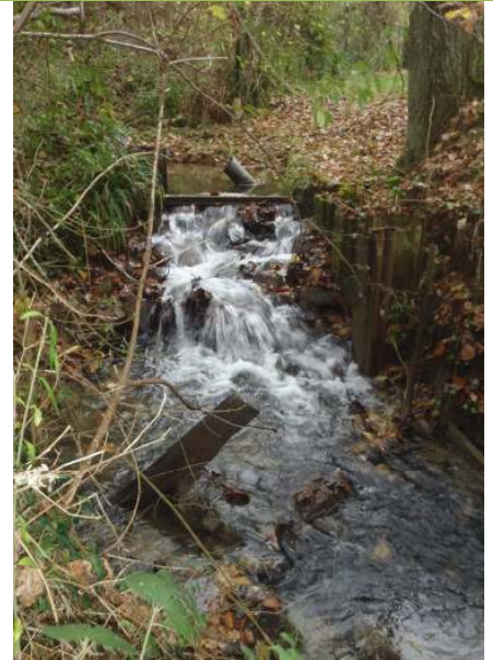
Vue aval de l'ouvrage « N°3 »
