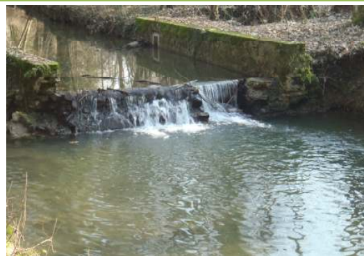
Ouvrage d'alimentation d'un étang
