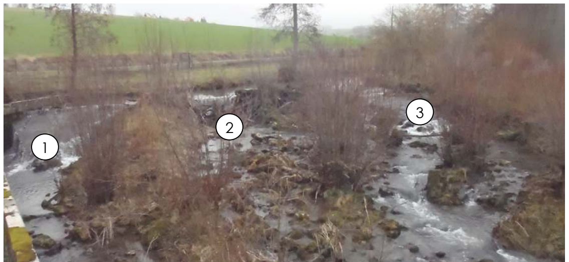
Vue globale de l' ouvrage de l' ancienne pisciculture
