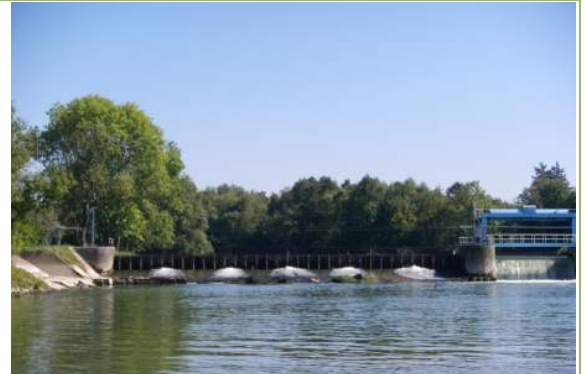
Vue aval du barrage de Berry-au-Bac
