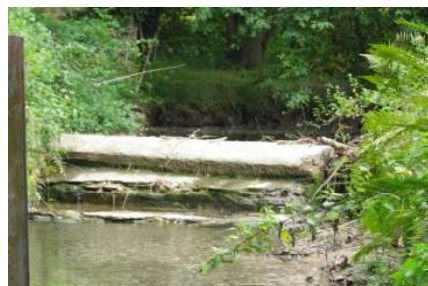
Ouvrage d'alimentation de l'étang
