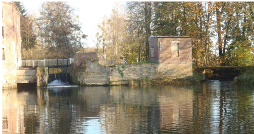
Vue aval du seuil de Leuze et du bras de décharge (à droite)
