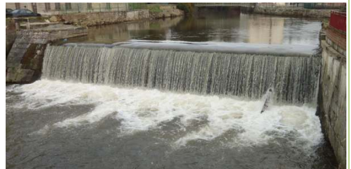
Vue aval du seuil Pasteur
