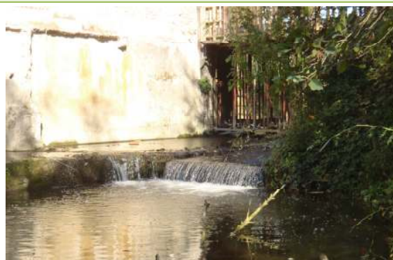
Vue aval du radier du moulin Neuf
