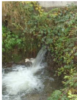
Vue aval de l'ouvrage
