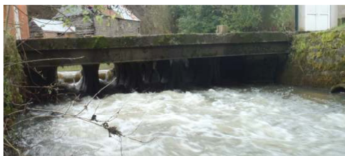
Vue aval des buses d'accès à la pisciculture
