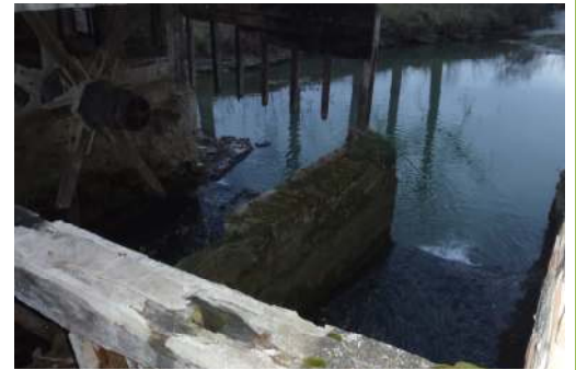
Vue amont du seuil résiduel du moulin de Dercy
