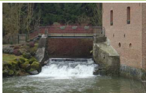
Vue aval du moulin de La Neuville-lès-Dorengt
