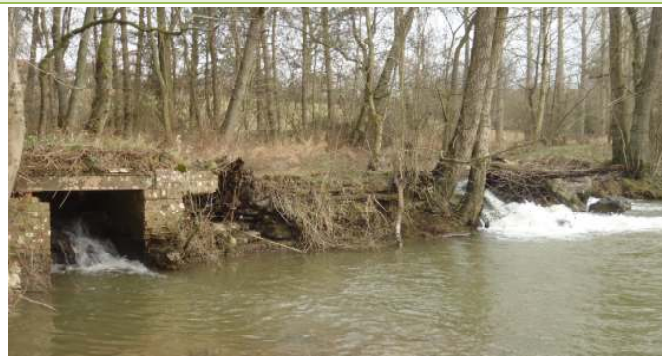
Vue aval de l'ancien déversoir de la Bovette
