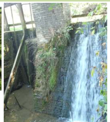
Vue aval de l'ouvrage de la ferme de Gironsart
