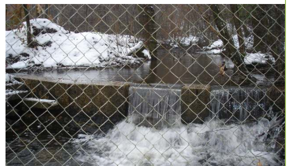
Ouvrage d'alimentation de l'étang (Crédits photo : LOGEZ C.)
