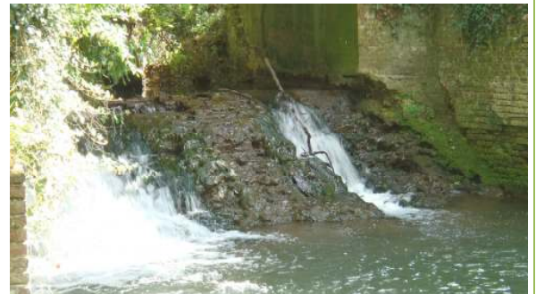
Vue aval de l'ancien moulin de Rabouzy
