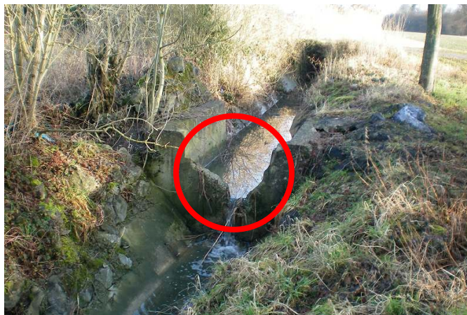
Ouvrage à reconstruire pour le bon cheminement des eaux vers le bassin de dépollution
