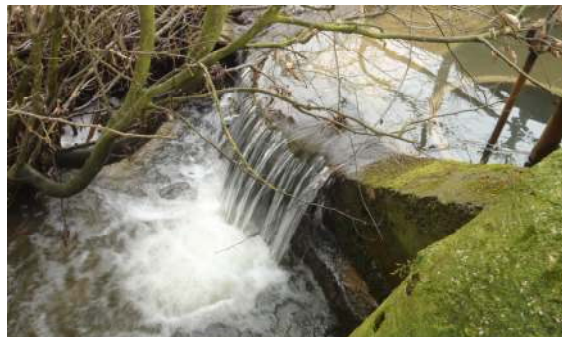
Seuil pour pompage agricole
