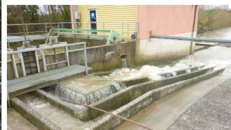
Vue aval de la centrale hydroélectrique de Chigny et de sa passe à poissons
