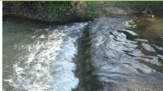
Seuil du passage à gué au niveau de l'île de Crézancy (N°3)
