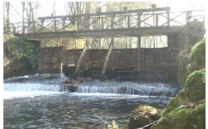
Vue aval de l'ancien moulin de Buirefontaine
