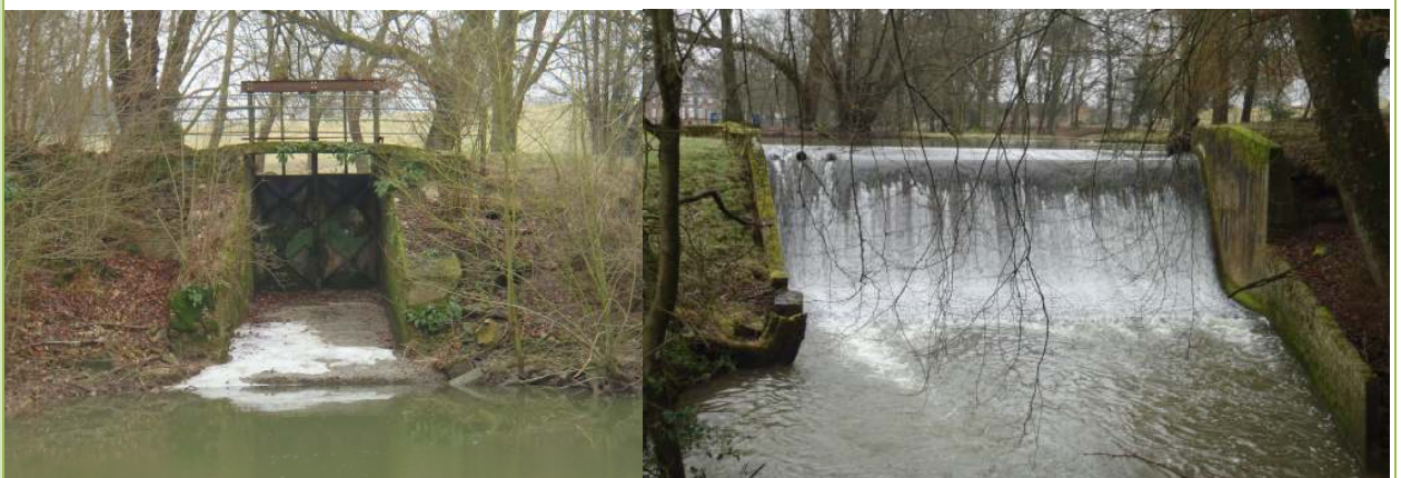
Vue aval du vannage (gauche) et vue aval du déversoir (droite)
