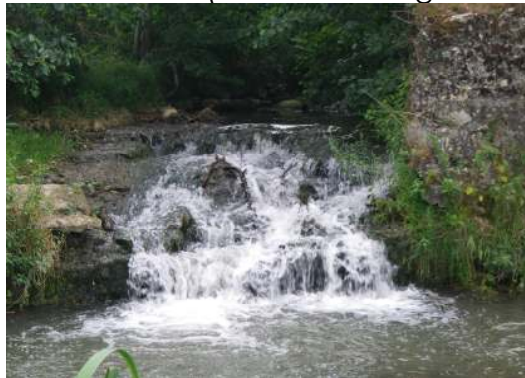
Rampe résiduel en rive droite
