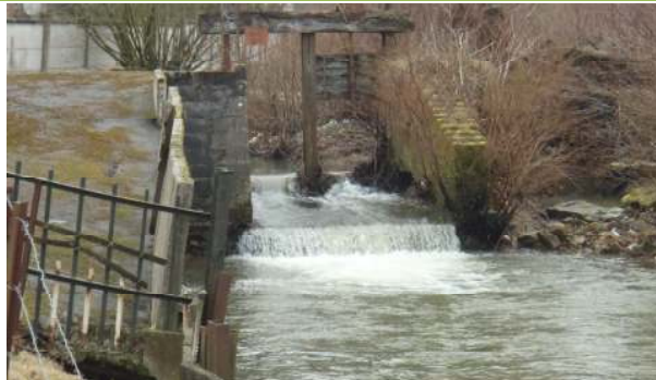
Vue aval de l'ouvrage d'Esquéhéries
