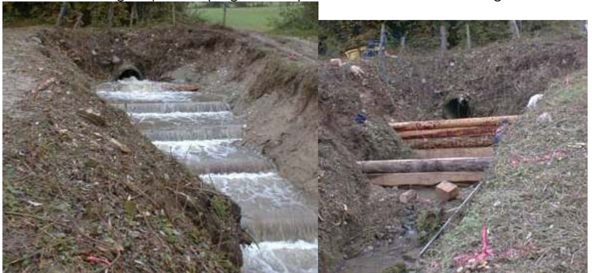
Exemple d'aménagement d'ouvrage par seuils successifs (Crédits photos : FPPMA74)
