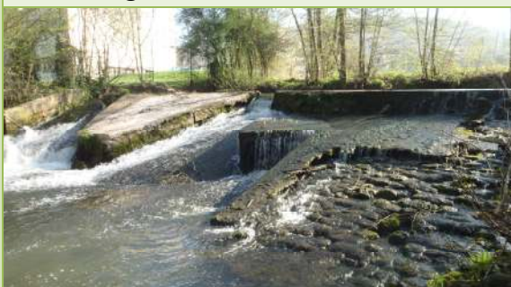
Ouvrage N°1 (ROE 31234)
