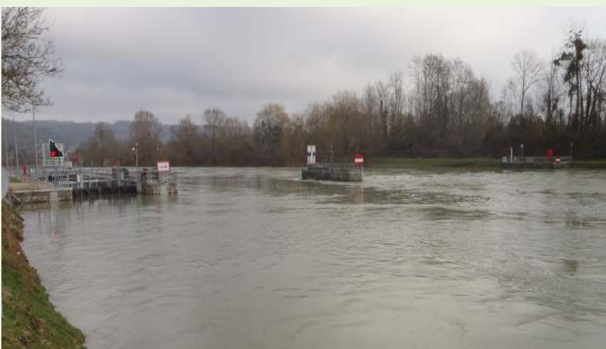
Vue aval du barrage de Méry-sur-Marne « transparent » en période de crue
