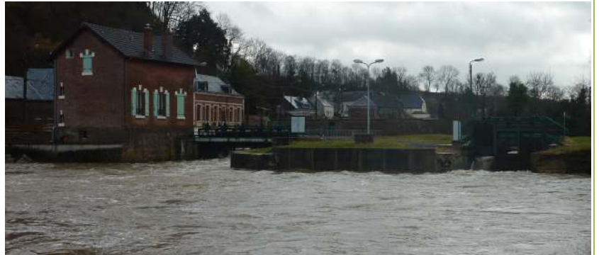
Vue aval du barrage de Lesquielles-Saint-Germain
