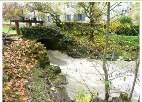
Chute principale au niveau des vannes
