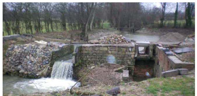
Vue aval de l'ancien moulin de Haut Bugny
