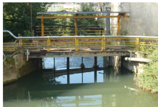
Vue amont de l'ouvrage de la papèterie
