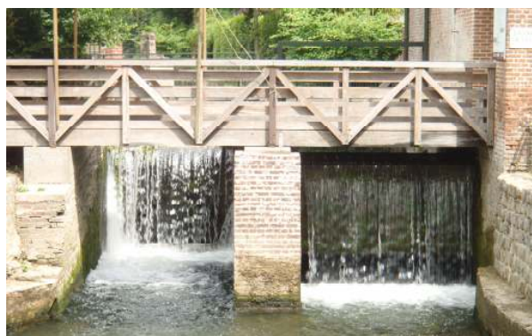
Vue aval du moulin du Temple
