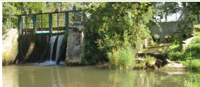
Vue aval du moulin de Rogny
