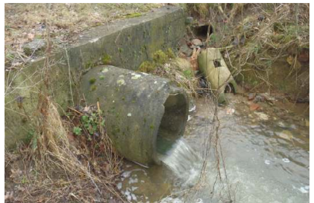
Aperçu du passage busé sous la RD774
