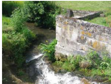
Vue amont de l'ouvrage
