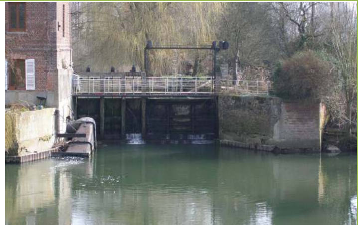
Vue aval du moulin de Tavaux (Crédits photo : GRIVEAUX A-F)
