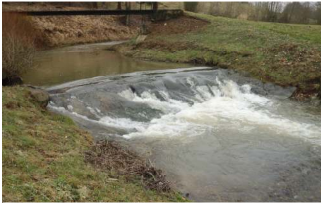
Vue aval de l'ancien moulin de Lavaqueresse
