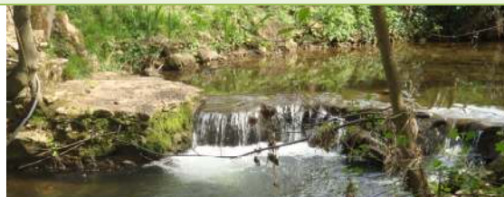
Seuil en pierre en aval de Pargny-la-Dhuys
