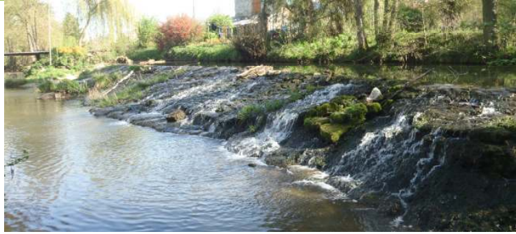
Ouvrage N°1 du moulin de Connigis (ROE 33475)
