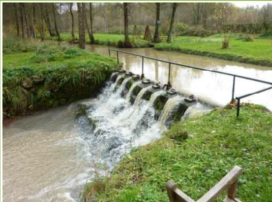
Déversoir du bras de décharge
