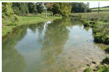
Remous de l'ouvrage de la ferme de Gironsart
