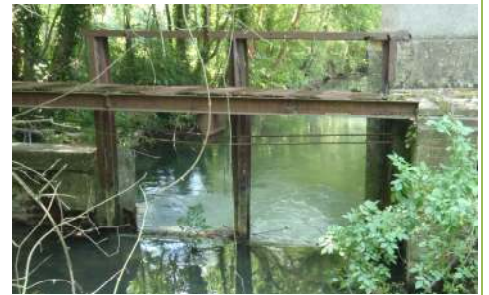
Vue amont de l'ouvrage N°3
