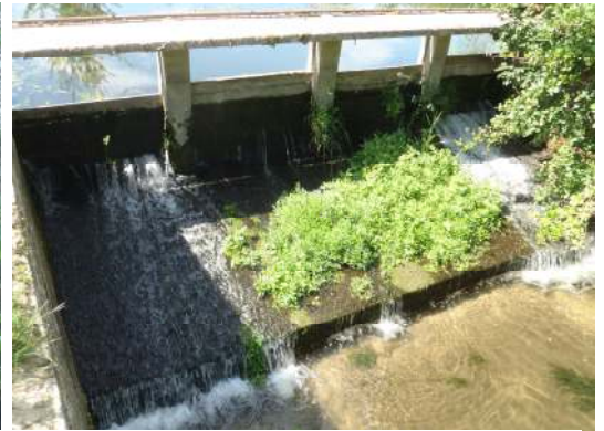
Déversoir du bras de décharge
