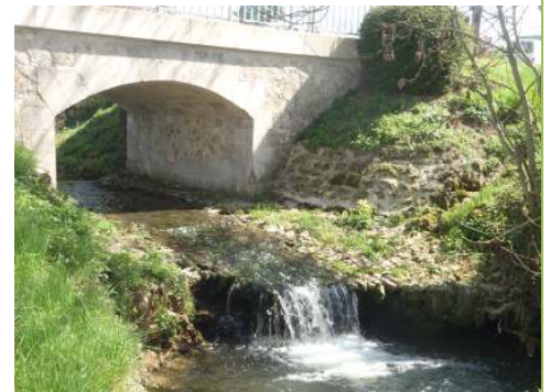
Seuil sous le pont de La Chapelle Monthodon
