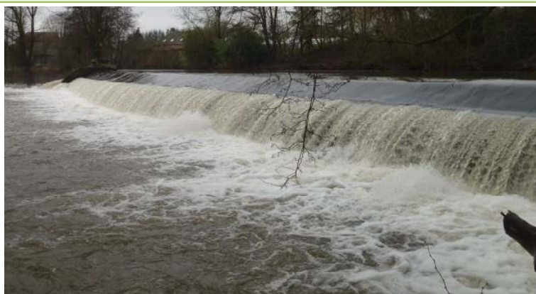
Aperçu du déversoir de l'usine hydro-électrique de Monceau-sur-Oise
