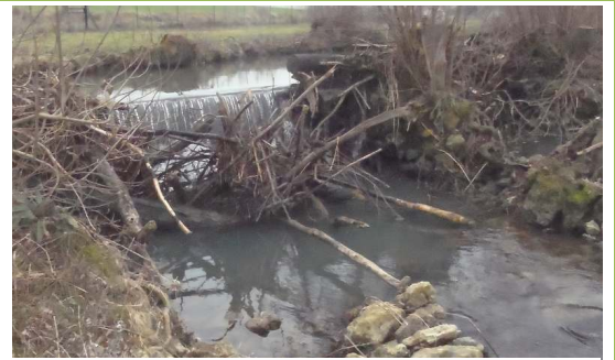
Partie N°2 de l'ouvrage constitué d'un déversoir
