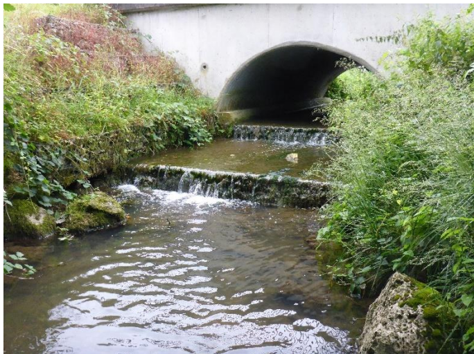
A gauche : ouvrage sur le ru du Cour Dimanche (ROE58096)
