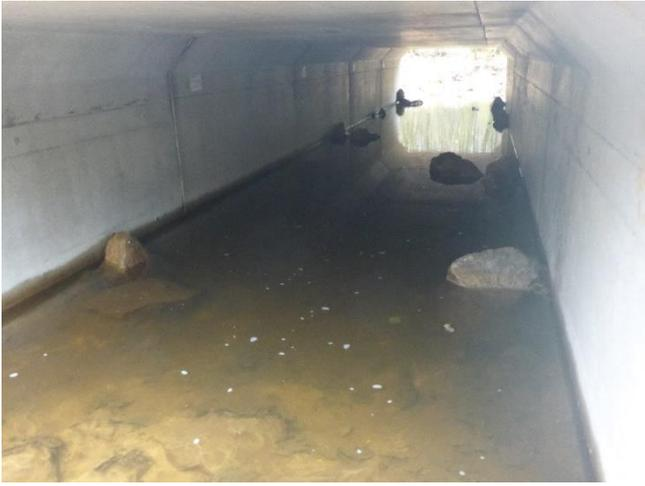
Les ouvrages ont été calés au plus près de la pente du cours et enterré d'au moins 30 cm sous le lit naturel du cours d'eau. Il a été choisi de ne pas réaliser de recharge granulométrique afin de favoriser l'implantation d'un substrat local. Des blocs ont cependant été déposés sur les parties latérales afin de favoriser le dépôt des sédiments et créer des zones d'abris.
