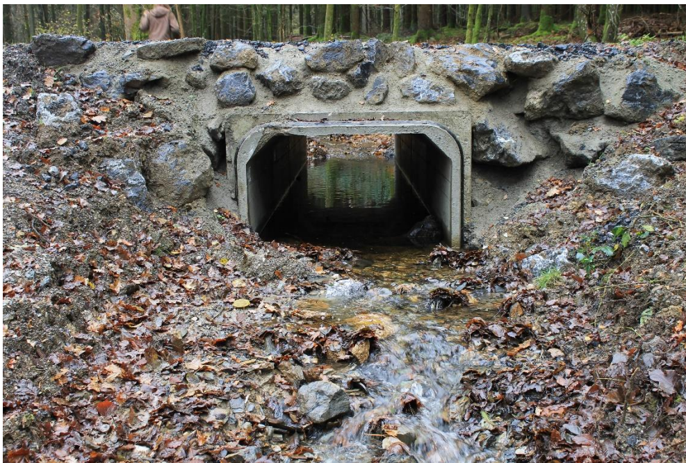
Figure 21 : exemple d'un cadre béton avec stabilisation
